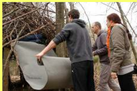
Nekaj nas je popravljalo streho zavetja za srne ...
